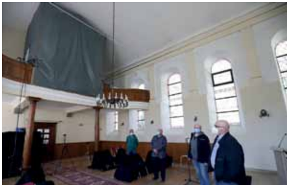
Ein Schaden an der Orgel muss noch repariert werden. Foto: Stephan Everling
