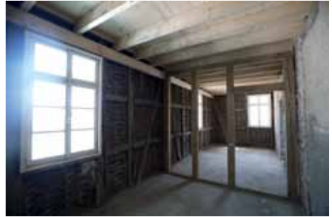
Die alte Verfachung an den Wänden ist noch zu erkennen. Foto: Stephan Everling
