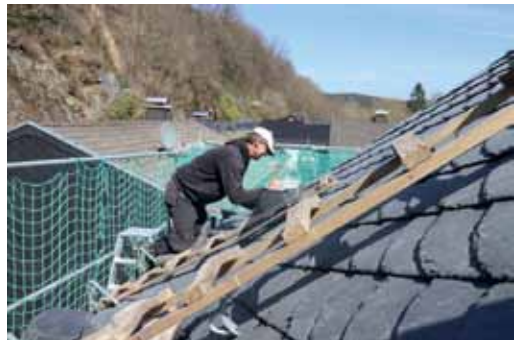
Dachdecker erneuern derzeit die Schieferschindeln der Hellenthaler Kirche. Foto: Stephan Everling
