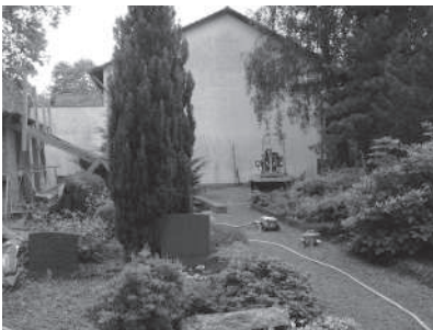
Die Stützkonstruktion wird in diesen Tagen abgebaut
