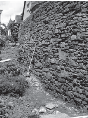
Die Mauer ist freigelegt
