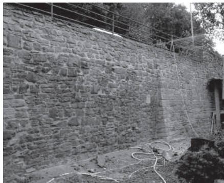
Fertig verfugtes Mauerstück
